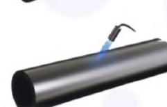
Pre caliente la superficie de la tubería sujeta a la aplicación de aislamiento
